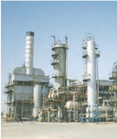
ب) نمای بیرونی برج تقطیر در پالایشگاه
